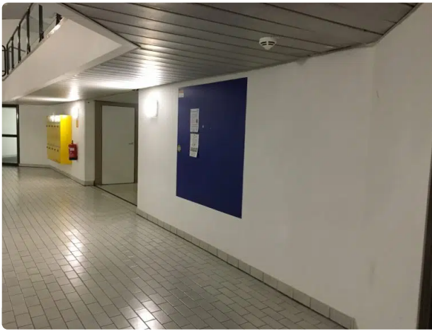
Verfügbare Flächen in der Lifthalle des Block C neben dem freien Anschlag.
